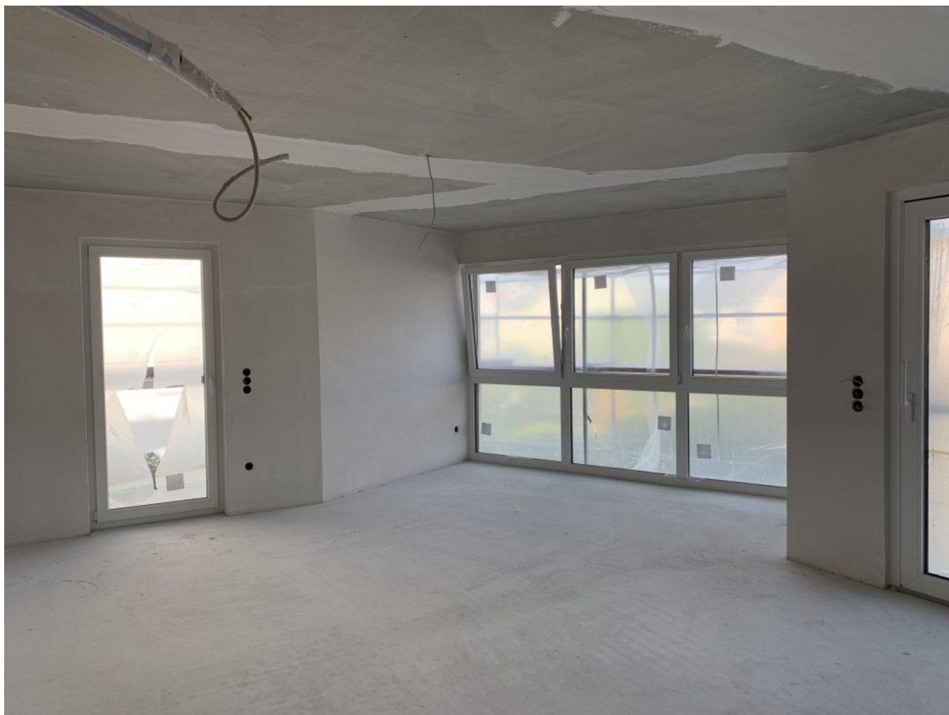
Wohnzimmer im Bau
